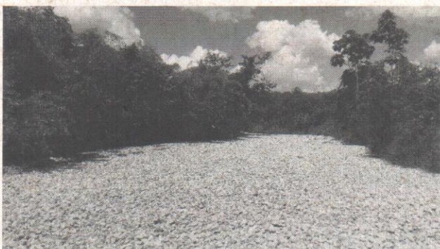
Vista do atual sistema de tratamento passivo
