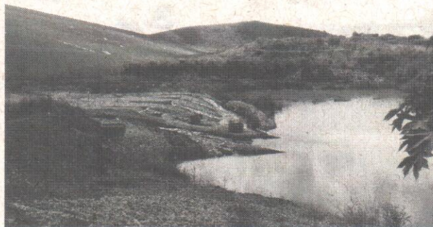
Vista da bacia de sedimentação dos drenos de fundo da barragem Eustáquio
