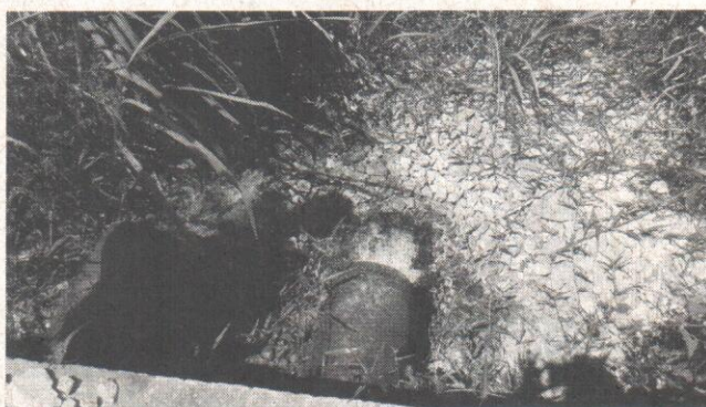
Saída da água residual no final do sistema de tratamento passivo
