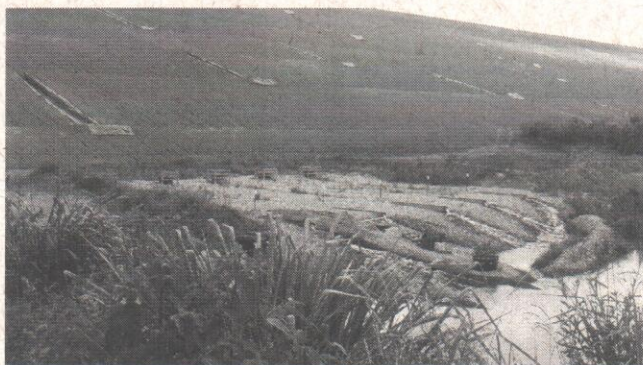
Vista do atual maciço e dos drenos de fundo da barragem Eustáquio
