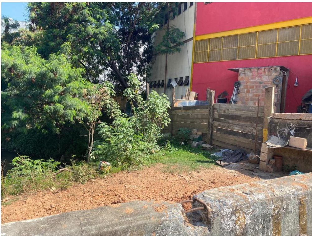
Figura 9 - Ponto sujeito a alagamento ocupado irregularmente.
