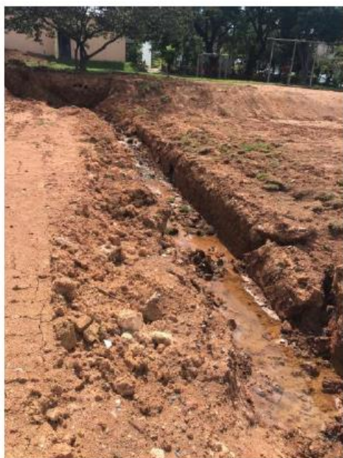
Figura 2 – Escavações com afloramento de água no local da outorga pretendida.
