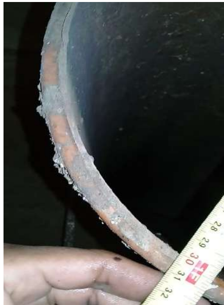
Figura 1 – Tubulação de 300 mm, encontrada no reservatório de 30.000lts
