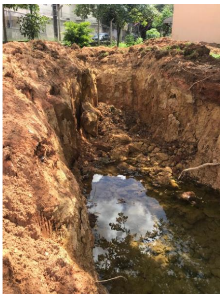
Figura 5-2: Escavação da OEC com afloramento de água.
