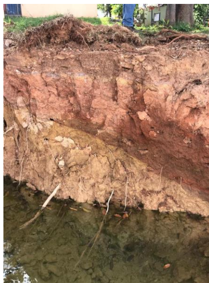
Figura 5-3: Escavação da OEC com afloramento de água.
