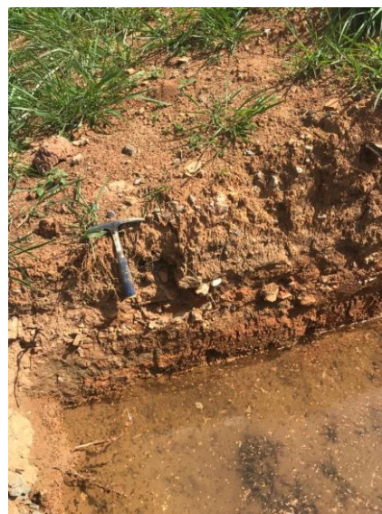
Figura 5-5: Escavação da OEC com afloramento de água.
