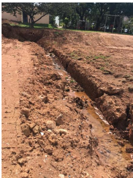
Figura 5-4: Escavação da OEC para direcionar o afloramento de água encontrado.
