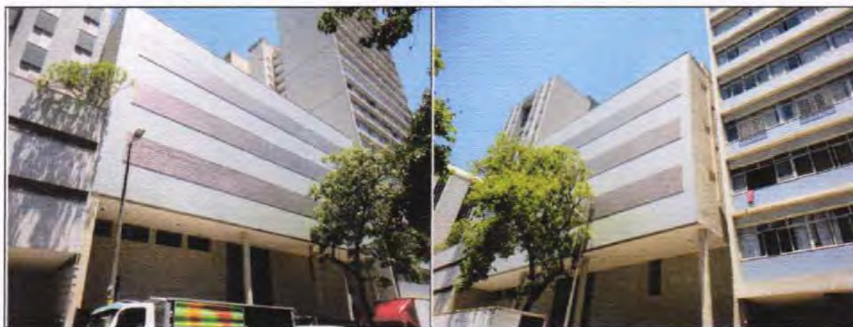
Figura 3.3 – Detalhes da atual fachada do edifício da SE BH Centro 2.
