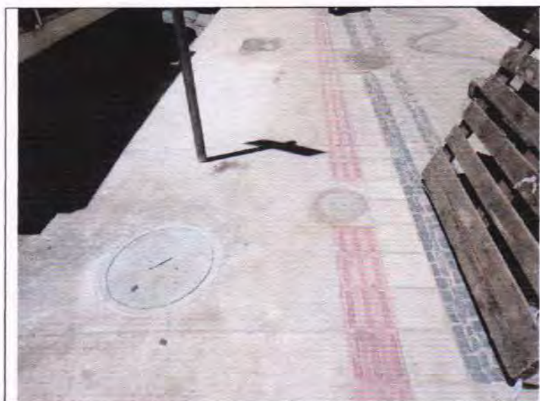
Figura 5.4 – Caixa da rede pública de águas pluviais.
