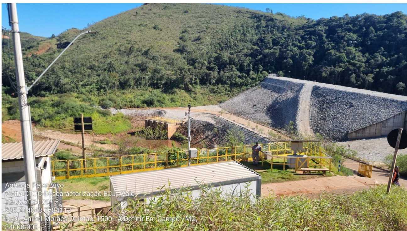
Figura 7 – Estrutura de contenção composta por enrocamento que será desmontada/descharacterizada.
