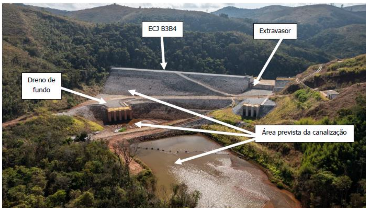
Figura 2 – Arranjo geral da ECJ atual e estruturas associadas com indicação do projeto de canalização.
