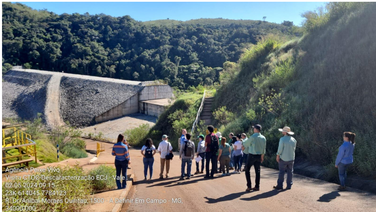
Figura 5 – Visita técnica realizada no local das intervenções propostas no dia 02 de maio de 2024.
