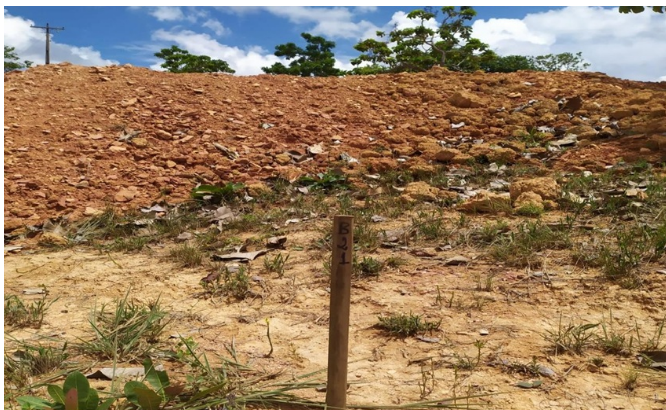
Figura 2: Barraginha sem compactação
