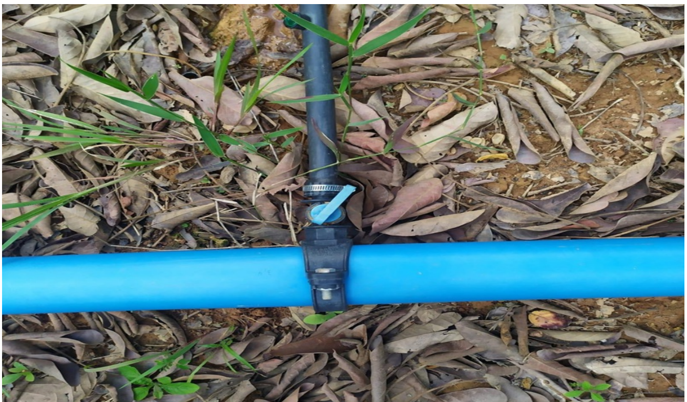
Figura 4: Abraçadeira improvisada no sistema de irrigação
