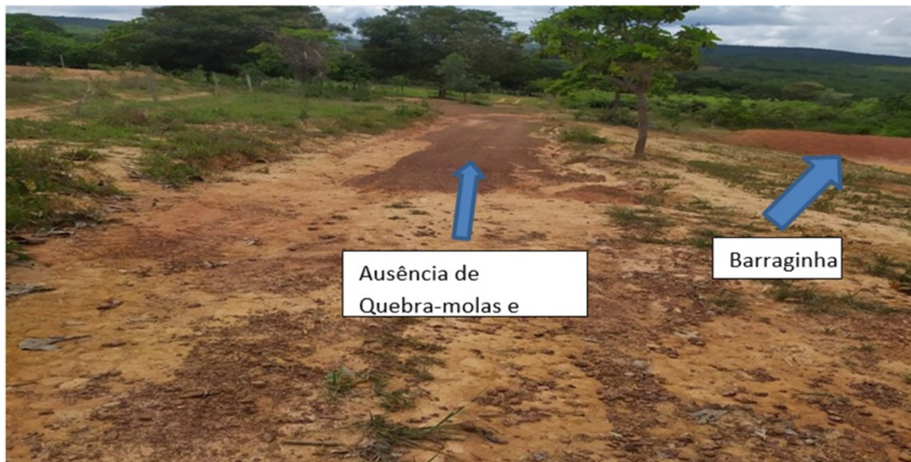
Figura 1: Ausência de Quebra-molas e bigode
