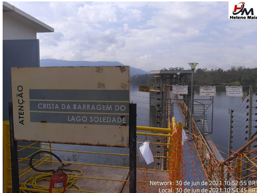
Foto 2: Crista da Barragem, ponto de captação e vertedouro da Barragem Soledade na Gerdau Açominas.
