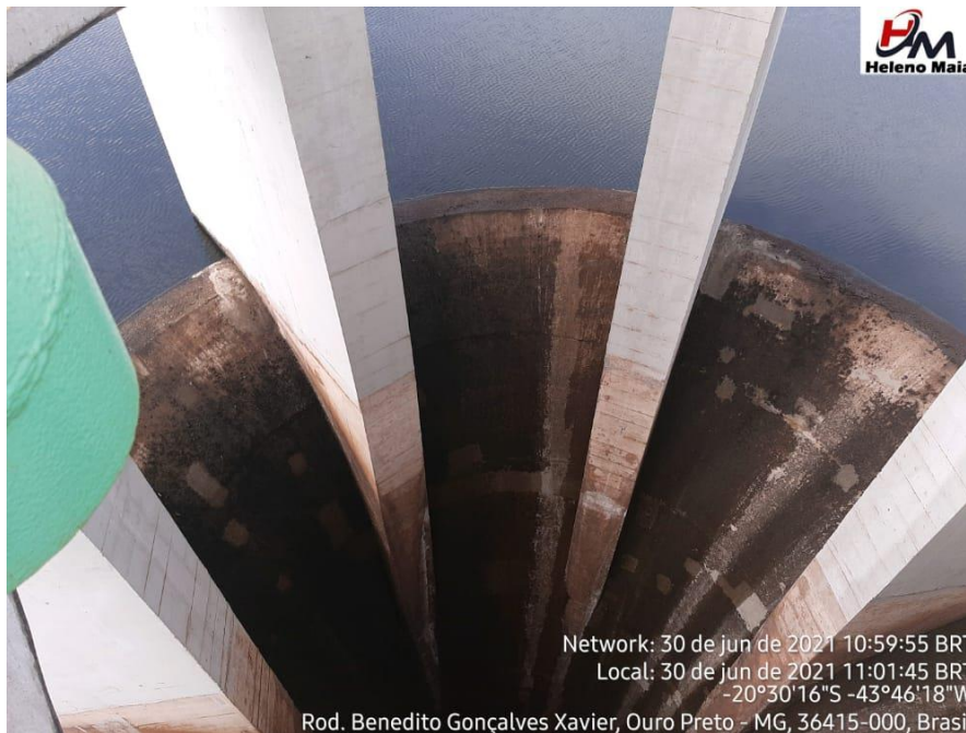
Foto 4: vertedouro da Barragem Soledade na Gerdau Açominas.
