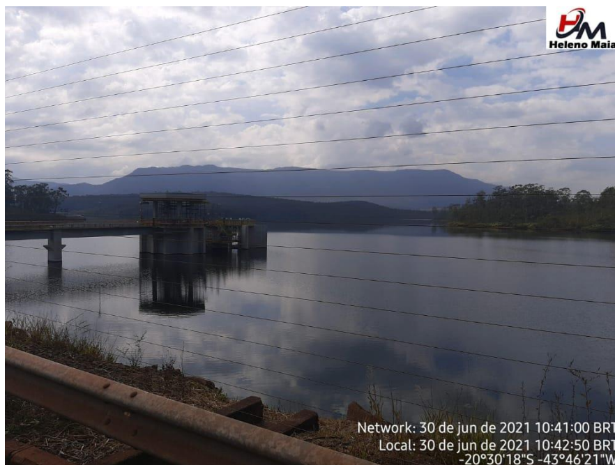
Foto 3: ponto de captação e vertedouro da Barragem Soledade na Gerdau Açominas.
