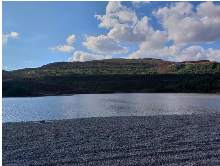
Foto 4: Vista geral da Pilha do Batateiro consolidada e dique de contenção de sedimentos à jusante.
