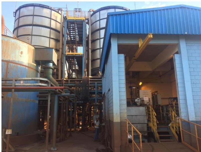
Foto 2: Processo de filtragem de rejeito em operação. O material gerado da filtragem será direcionado para a área de empilhamento sobre os drenos de fundo do Fraile.
