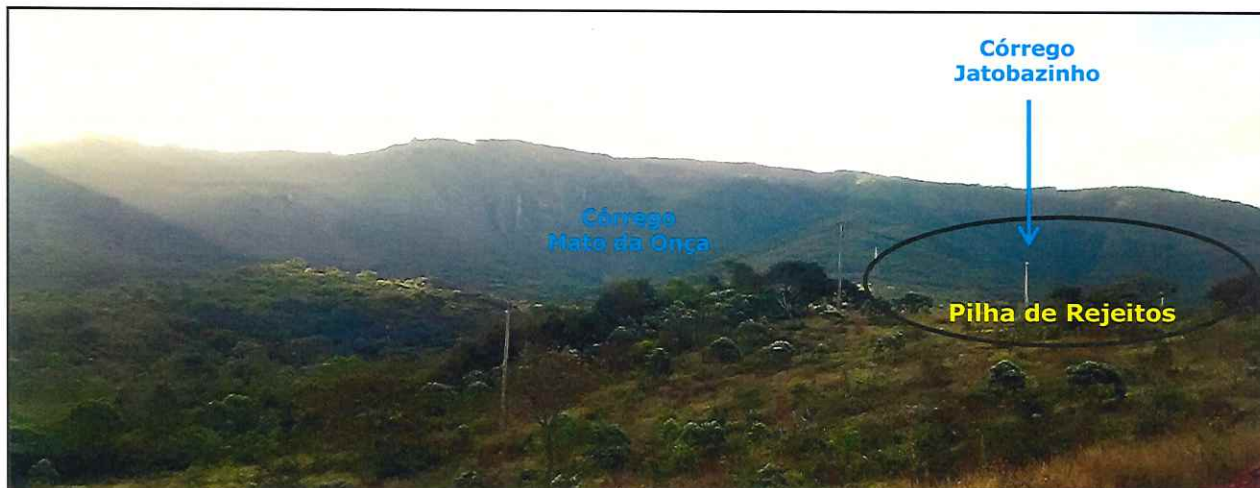
FOTO 6.1 – Vista do vale do córrego Jatobazinho, local de inserção da Pilha de Rejeitos
