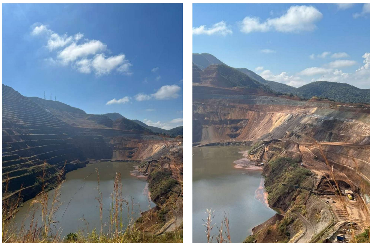
Figura 4: Imagem da atual disposição em cava com destaque para os instrumentos de disposição. Fonte: Membros da CTIOAR (2024)
