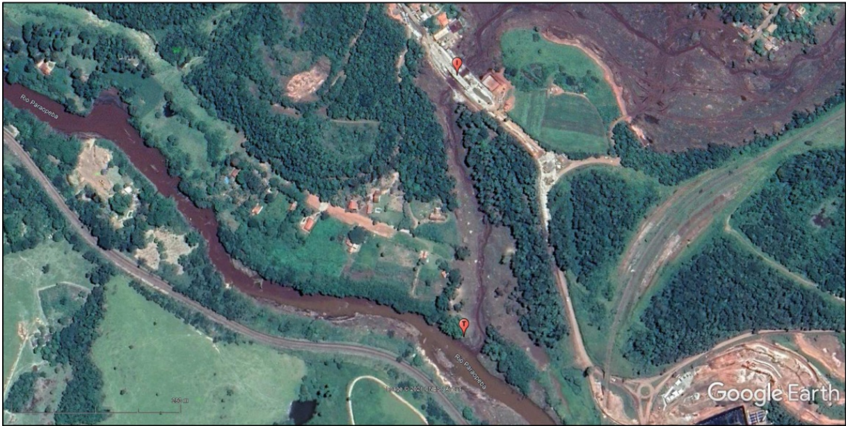
Figura 1: Visão geral de localização da nova canalização aberta destinada à restauração da calha fluvial do Ribeirão Ferro Carvão, Mina Córrego do Feijão, zona rural do município de Brumadinho.
