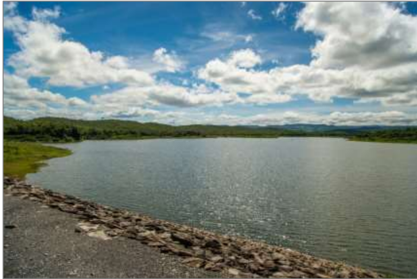
Figura 4: Barragem Juramento, município de Juramento-MG.
