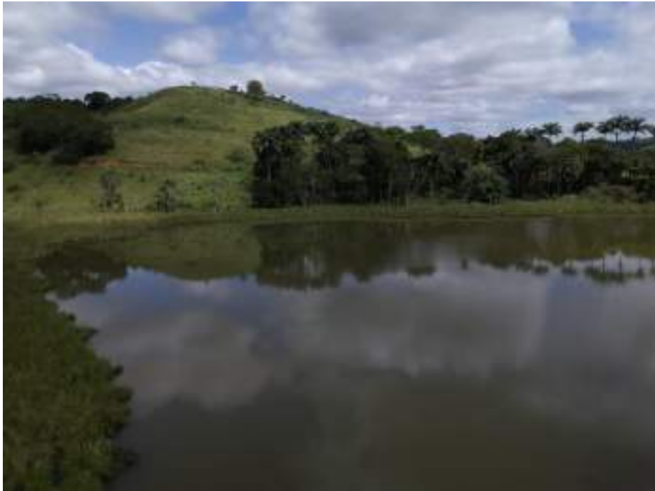
Figura 6 – Vista superior do barramento.
