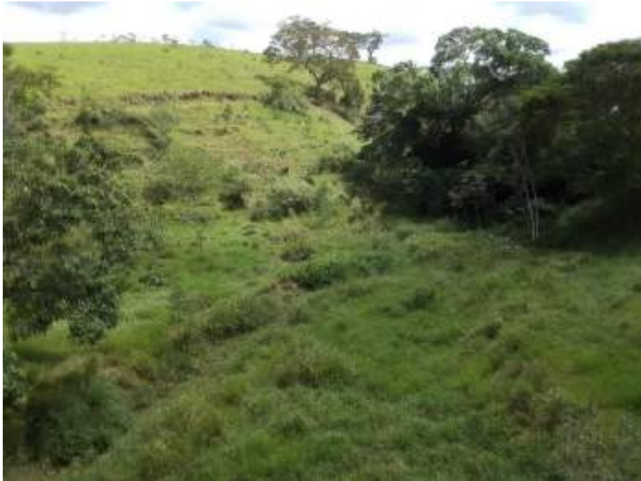
Figura 10 – Vista superior do canal de desvio a jusante do barramento; o curso d'água receptor possui nascente na mata no canto superior direito.
