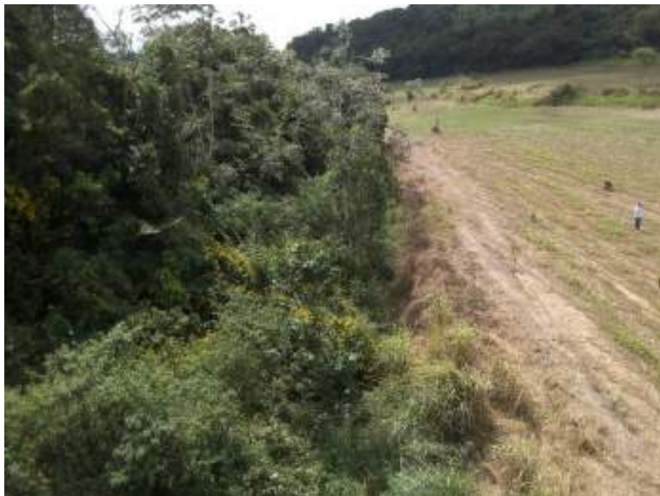
Figura 12 – Vista dos drenos de várzea existentes na microbacia doadora (que recebia a água do curso d'água antes do desvio).
