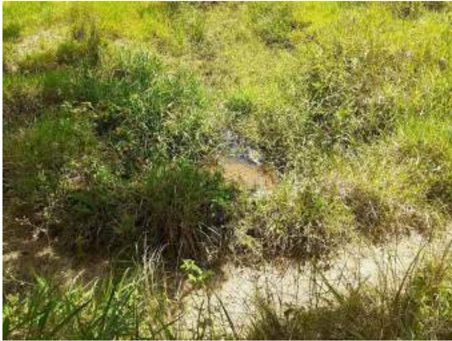
Figura 8 – Canal de desvio a jusante do barramento.
