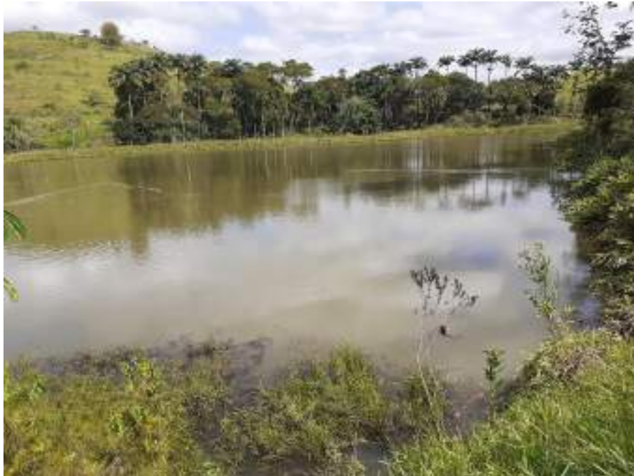
Figura 4 – Vista frontal do barramento, a partir da barragem.
