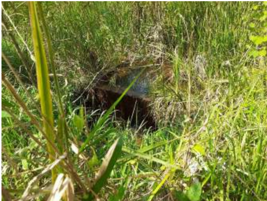
Figura 7 – Vista do canal de extravasamento lateral do barramento, que desvia as águas recebidas para o curso d'água afluente do Ribeirão Liberdade.
