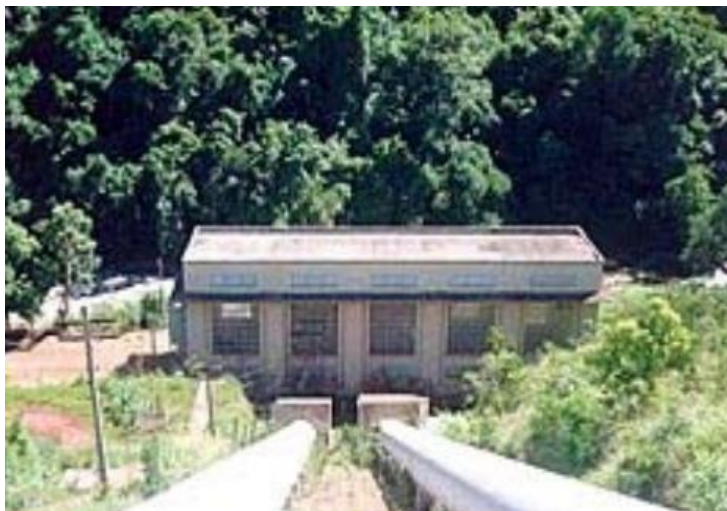
Figura 4: Vista Geral da Casa de Força
