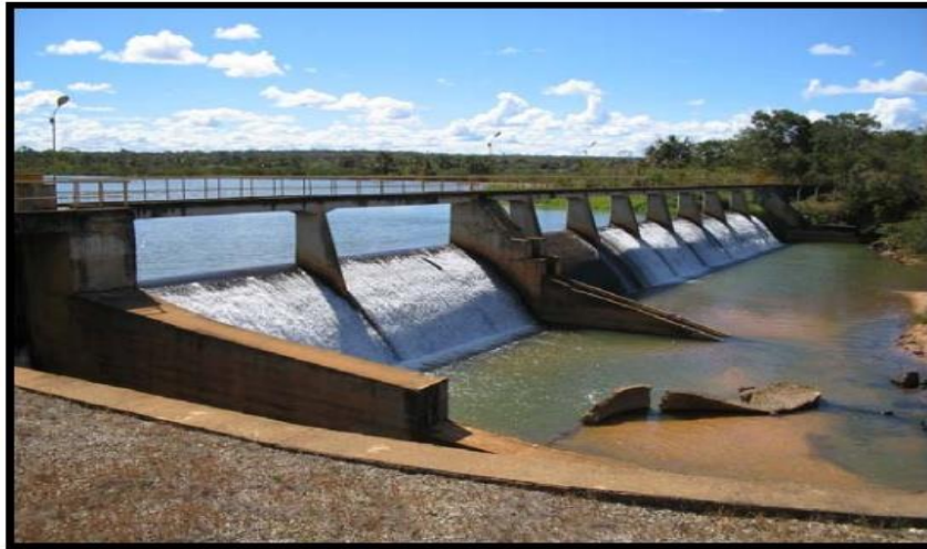
Figura 1. vista parcial, de Jusante, da Barragem
