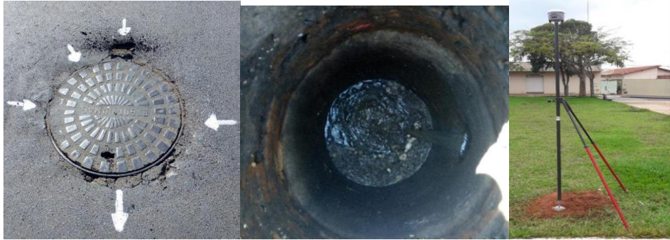
Registro dos serviços realizados com o GRP (GeoRadar) no município de Nova Ponte – MG.
