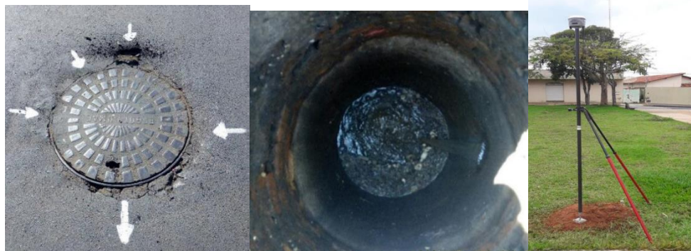
Registro dos serviços realizados com o GRP (GeoRadar) no município de Nova Ponte – MG.
