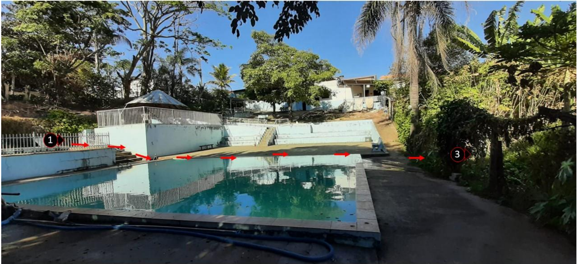
4 – Vista lateral do sentido do fluxo do escoamento da água até a tubulação que coleta a água e entrega na caixa de locação.
