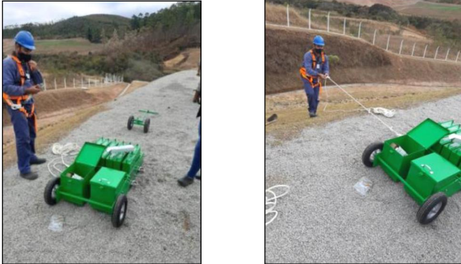
Figura 2.8.1: Dispositivo de ancoragem móvel
