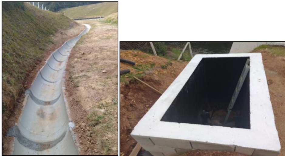
Figura 2.8.1.1.2: Sistema de Dreno Invertido
