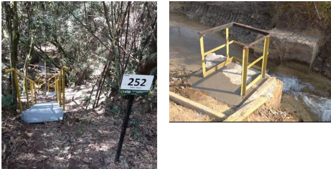
Figura 2.7.13.1: Melhorias nos pontos de controle
