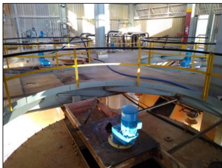
Figura 2.7.1.2: Manutenções na ETE-1
