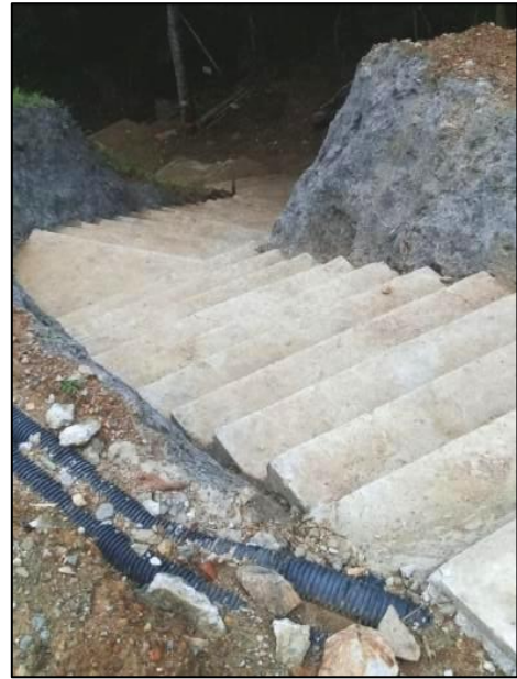
Figura 2.7.10.1: Adequação da estação de bombeamento da Barraginha
