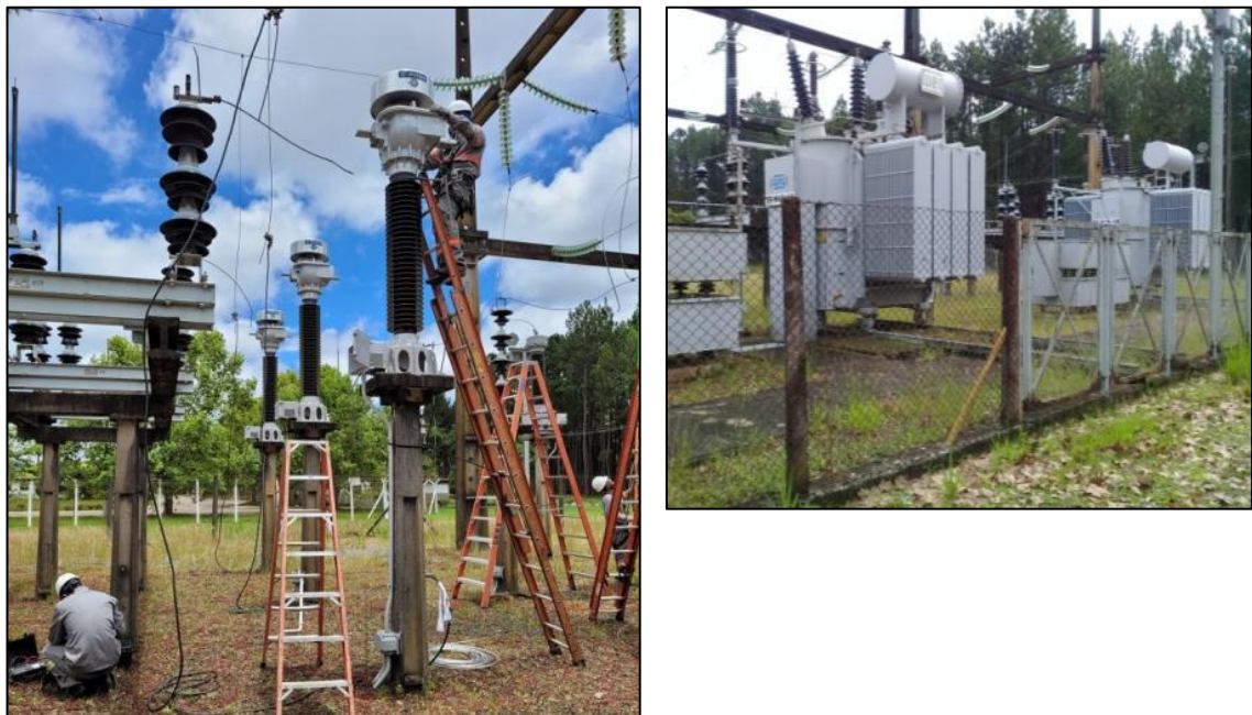
Figura 2.7.1.1: Manutenções na Subestação Principal
