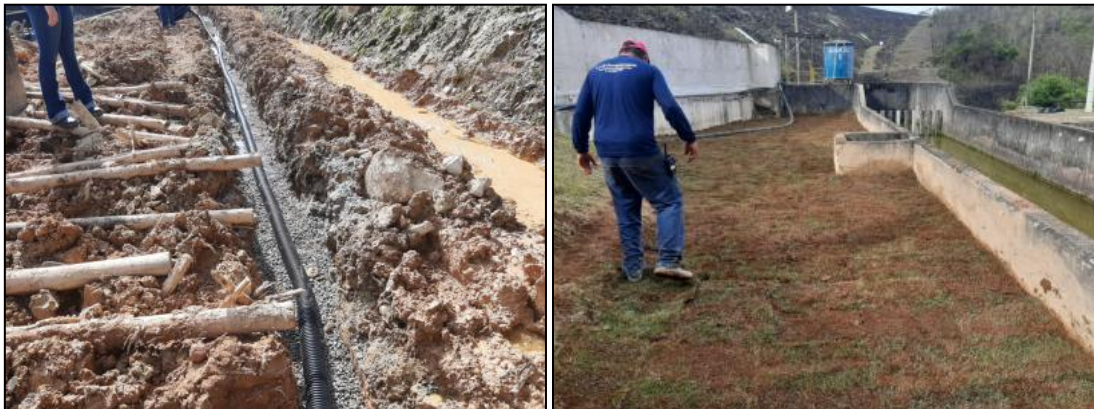
Figura 2.8.2.1.1: Andamento da obra em 11/2021 e 12/2021
