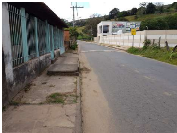
Figura 7 – Bueiro de escoamento pluvial na rua Félix dos Santos.
