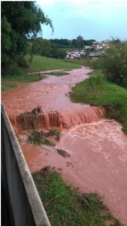
Figura 5 – BSTC Ø 1,00 m, vista de jusante para montante.
