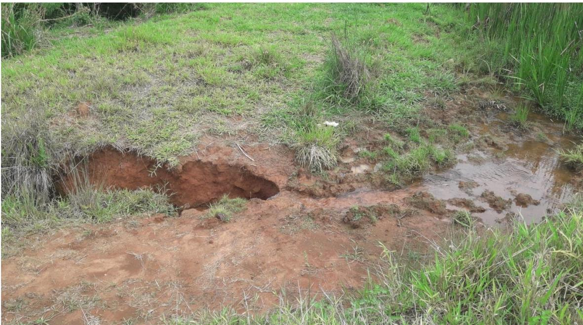
Figura 6 - Visualização da descarga do açude, na qual fica evidente o desenvolvimento do processo erosivo que, caso não seja contido, pode vir a ocasionar o arrombamento
