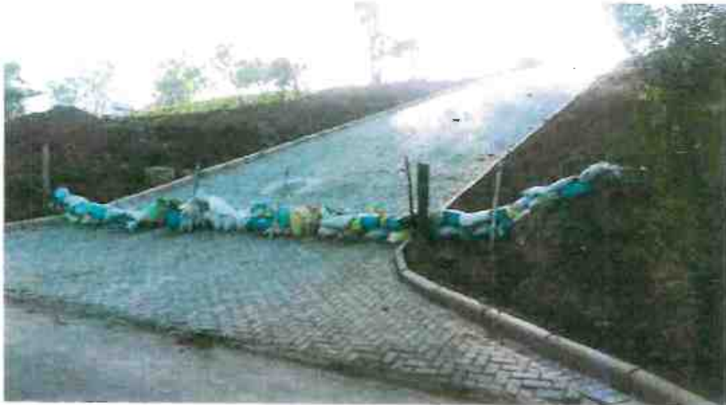
FOTO 03: SISTEMA DE CONTENÇÃO TIPO "RIP RAP"
