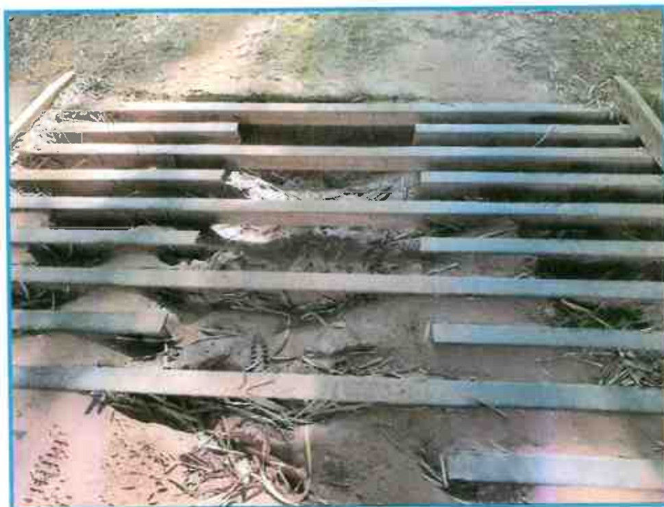
Figura 9 – Mata-burro tomado pela movimentação de solos do loteamento. Fonte: registro fotográfico autoral (vistoria in loco ).
