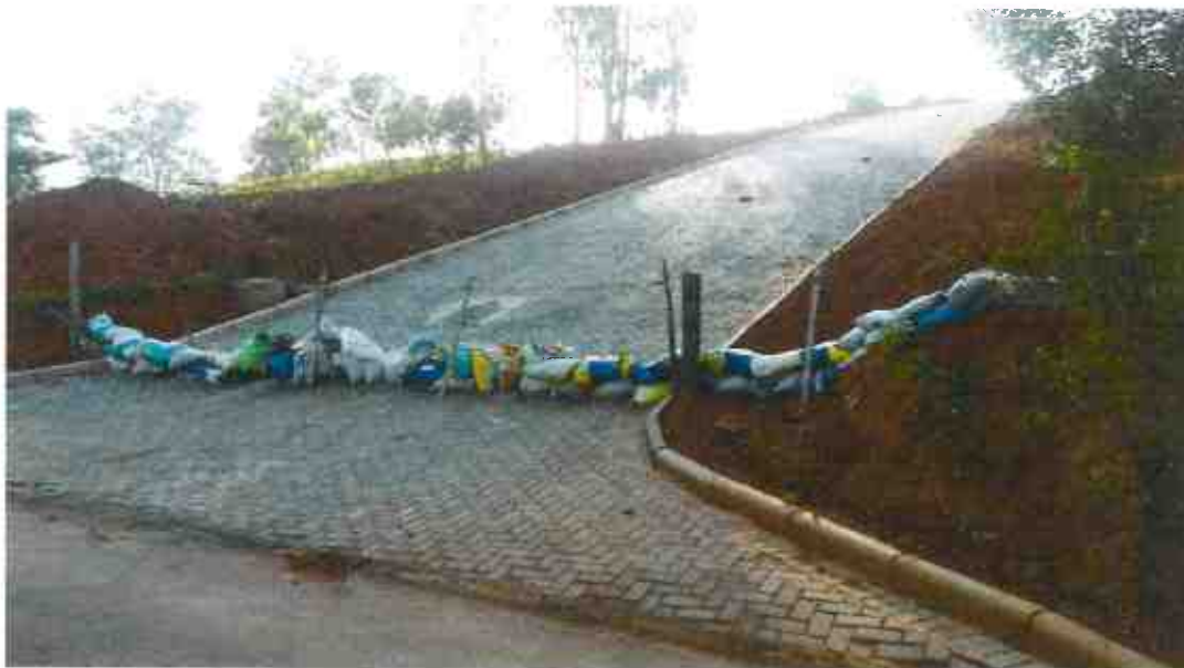
FOTO 03: SISTEMA DE CONTENÇÃO TIPO "RIP RAP"
