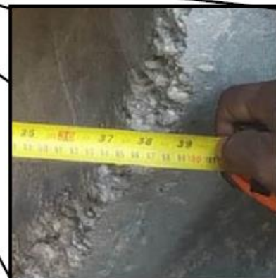
Figura 3 – Diâmetro da tubulação Fonte: MINAGEM GEOLOGIA E MINERAÇÃO (2023)
