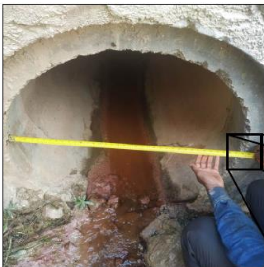
Figura 8 - Medição diâmetro da manilha
