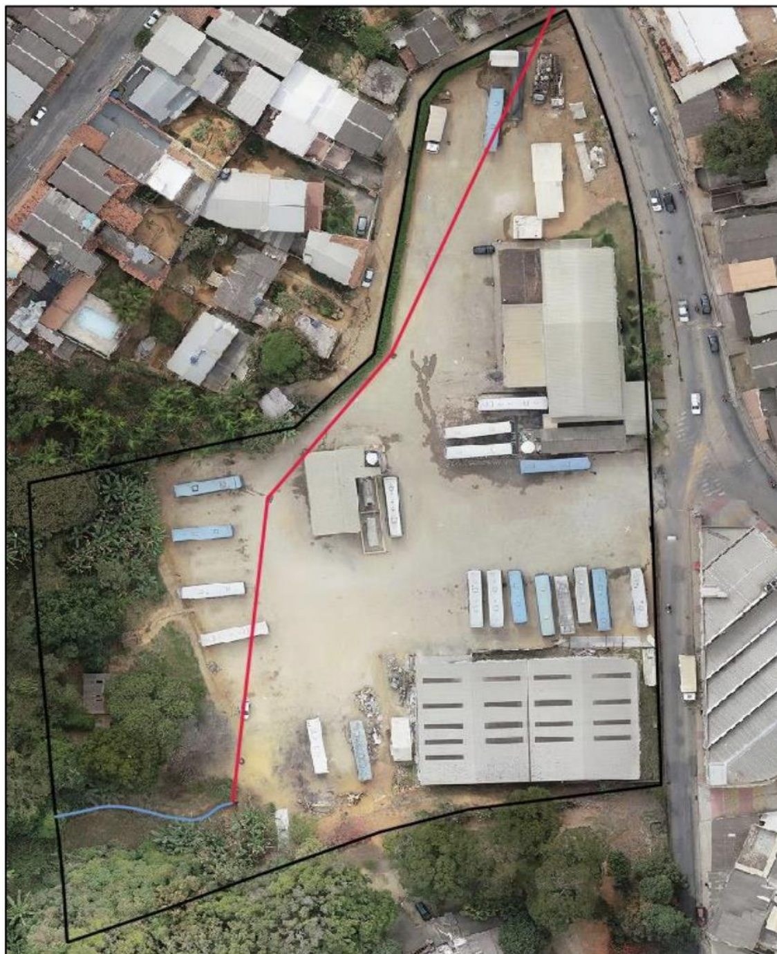
Figura 4 - Trecho de 32,4 m a ser canalizado (em azul) e identificação da área da garagem da linha de ônibus municipal onde o curso d'água foi canalizado a jusante (linha vermelha)
