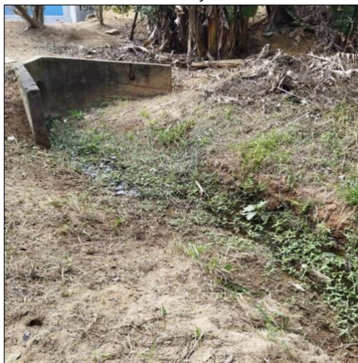
Vista da canalização a jusante do trecho da intervenção
