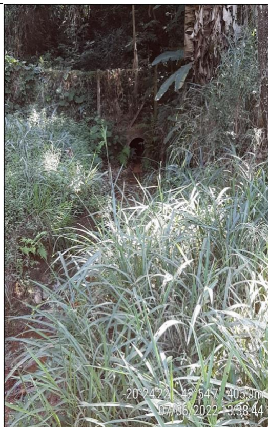
Vista da canalização a montante do trecho da intervenção
