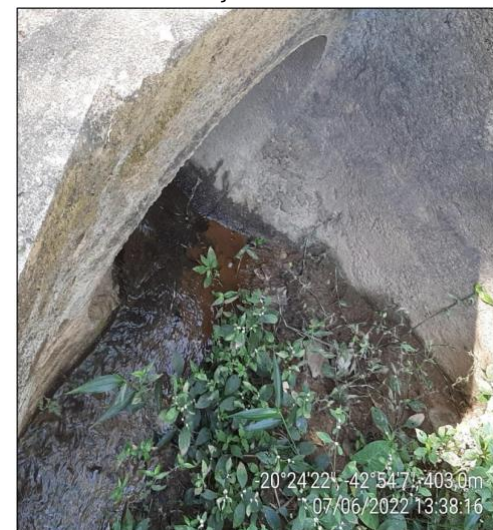
Entrada da canalização a jusante do trecho da intervenção
