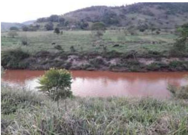
**Foto 7:** TR15-01-Talude na margem esquerda do rio Gualaxo do Norte com foco erosivo em estágio avançado
