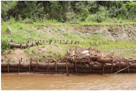
**Foto 13:** Bioengenharia com presença de material arrastado do Trecho 6.
