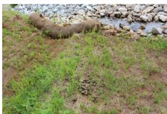
**Foto 4:** Bioengenharia às margens do Piloto do Projeto de Renaturalização do Trecho 6 para controlar o sistema de drenagem da área e minimizar o arraste de sedimentos nesses trechos
