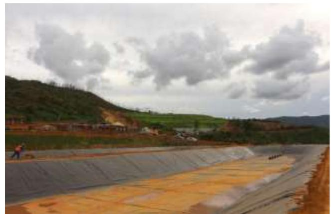
**Foto 18:** Lagoas Facultativas em paralelo – Estação de Tratamento de Esgoto
