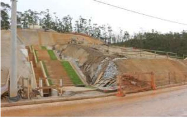
**Foto 13:** Sistema de Drenagem Pluvial da área da ETA
