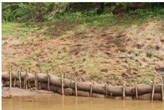
**Foto 9:** Presença de pisoteio de bovinos e equinos na hidrossemeadura, tornando o sistema ineficaz do Trecho 6
