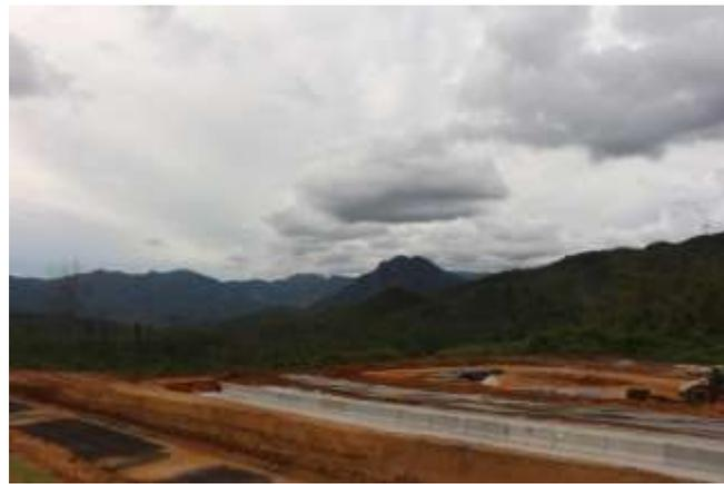
**Foto 20:** Lagoas de Maturação – Estação de Tratamento de Esgoto
