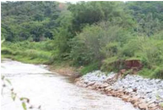
**Foto 9:** Enrocamento à margem direita.
