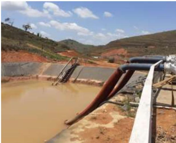
**Foto 3:** Sistema 2 de Bombeamento de Efluentes – Sump 2.
