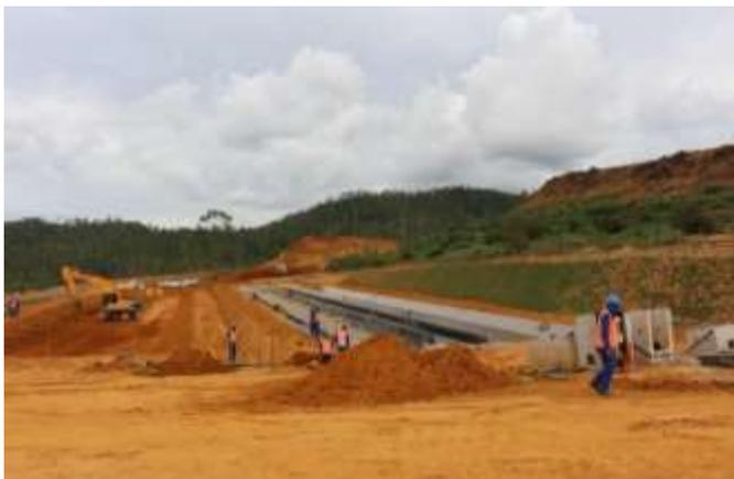
**Foto 19:** Lagoas de Maturação – Estação de Tratamento de Esgoto
