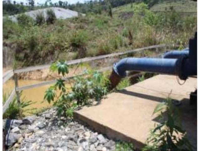
**Foto 2:** Sistema 1 de Bombeamento de Efluentes – Sistema de Sucção.
