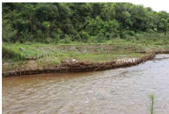
**Foto 12:** Bioengenharia com presença de material arrastado do Trecho 6.
