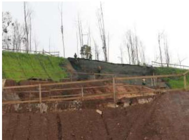
**Foto 10:** Instalação de solo grampeado verde.
