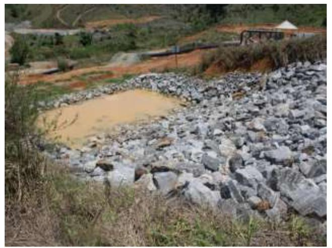
**Foto 6:** Sistema de Drenagem Pluvial – Dique 1B- Vista 2 (Da crista do Dique).
