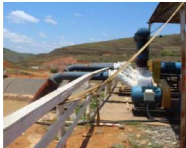
**Foto 4:** Sistema 2 de Bombeamento de Efluentes – Bombas.
