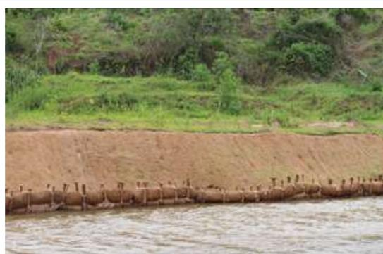
**Foto 23:** Presença de bioengenharia no trecho 07, piloto de renaturalização e atuação de replantio na área para regeneração.
