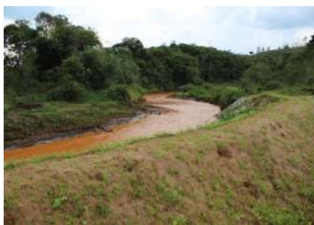
**Foto 15:** Utilização de técnicas de bioengenharia no rio Gualaxo do Norte: bermalonga (margem direita), hidrossemeadura (margem esquerda).
