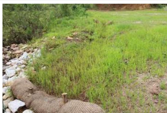
**Foto 5:** Bioengenharia às margens do Piloto do Projeto de Renaturalização do Trecho 6 para controlar o sistema de drenagem da área e minimizar o arraste de sedimentos nesses trechos.
