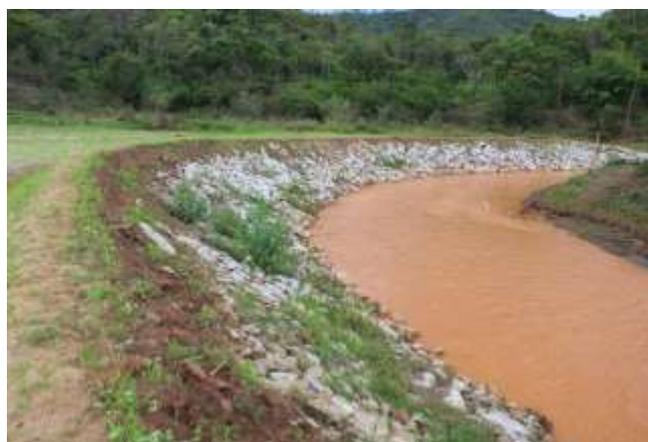
**Foto 14:** Implantação de enrocamento na margem esquerda
