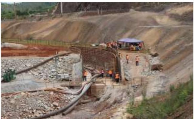
**Foto 5:** Obras de construção do Extravador do Eixo 1.
