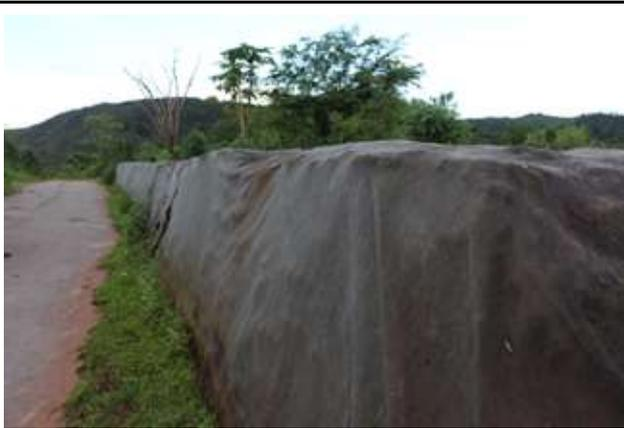
**Foto 3:** Vista Lateral do Muro de Pedras do Dique S4 protegido.
