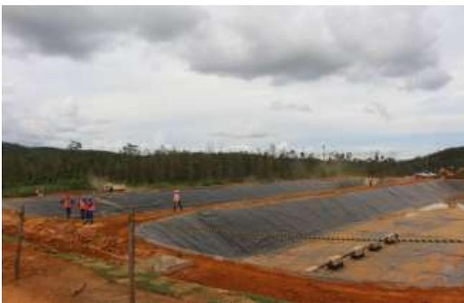
**Foto 17:** Lagoas Facultativas em paralelo – Estação de Tratamento de Esgoto
