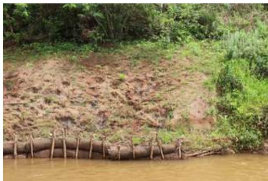
**Foto 8:** Presença de pisoteio de bovinos e equinos na hidrossemeadura, tornando o sistema ineficaz do Trecho 6.
