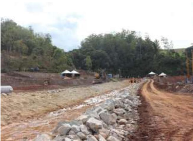
**Foto 15:** Construção do Sistema de Drenagem – Utilização de matacões.
