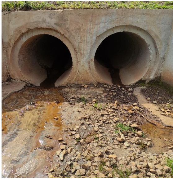
Foto 11: Ponto ITS05: Propriedade B11. Implantação de bueiro duplo em tributário.
