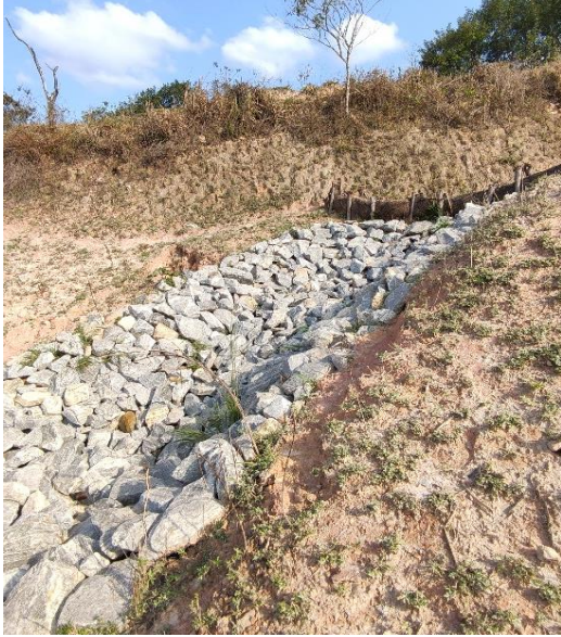
Foto 15: Ponto ITS06: Propriedade B16. Enrocamentos.
