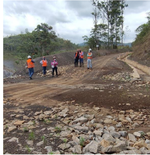
Foto 1 - b: Trecho 3: Sistema de Drenagem ITS01
