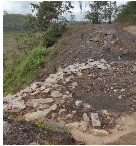
Foto 2 - b: Trecho 3: Necessidade de repasse da hidrossemeadura no Talude do Cânion T3.
