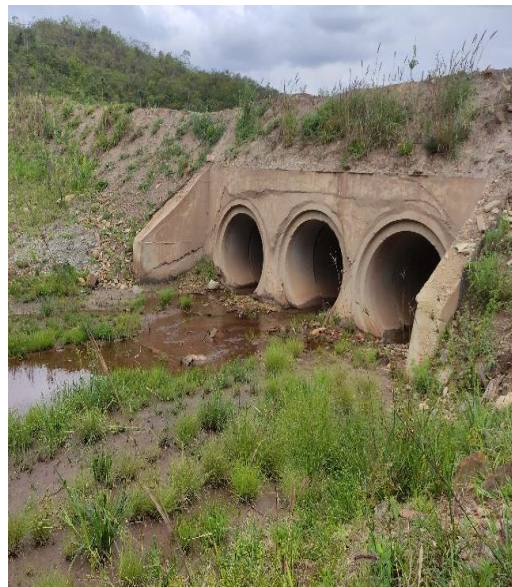
Foto 6: Ponto ITS02: Propriedade E002. Tributário com a instalação de um bueiro triplo.
