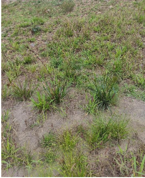
Foto 7: Ponto ITS02: Propriedade E002. Presença de hidrossemeadura com falha e recobrimento vegetal dos taludes insatisfatório.
