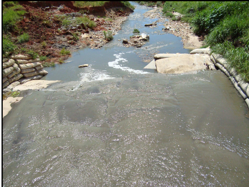
Ilustração 2: Vista de jusante para montante do trecho em análise
