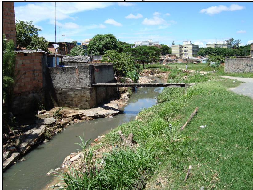
Ilustração 3: Vista de montante para jusante do trecho em análise.
