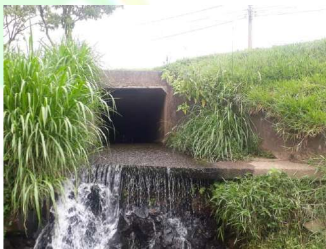
Figura 20: canalização do curso d'água no final do lote (coordenadas: 334951.133, 7590175.888, Sirgas 2000 23 S).
