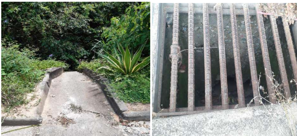
Figura 14: elementos do sistema de drenagem urbana
