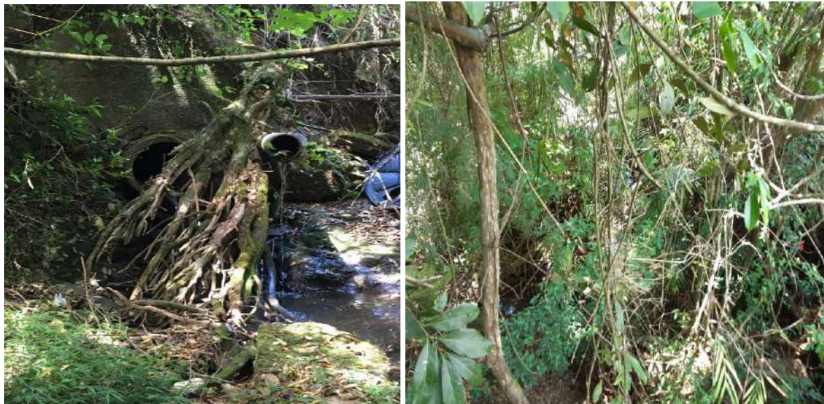
Figura 12: canalização ponto 1 (Coordenada: 334004.196, 7589846.060, Sirgas 2000 23S)
