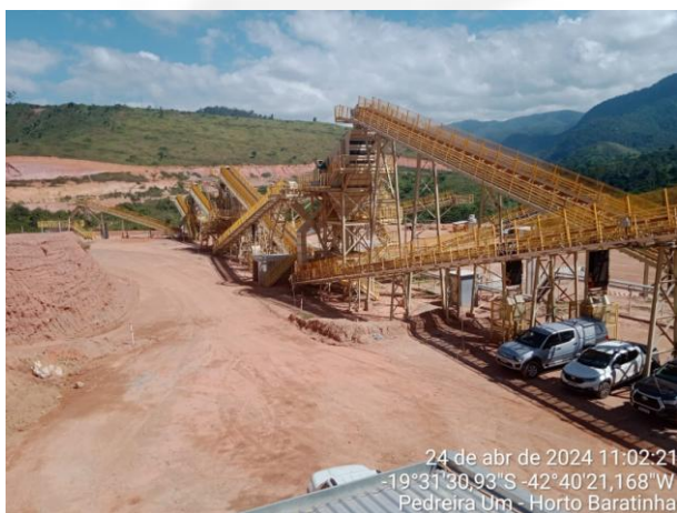
Foto 03: Vista da UTM.
