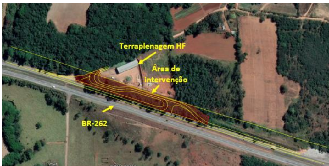
Figura 1 - Visão geral do empreendimento e área de intervenção (destaque em vermelho). Fonte: Adaptado do Google Earth Pro/2021.
