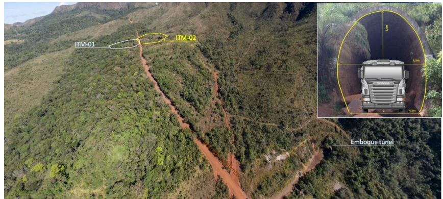
Escoamento produção interna com vinculação no túnel da Ferrovia do Aço
