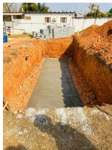
Foto 02. Caixa de gordura da ETE em obras (ampliação)
