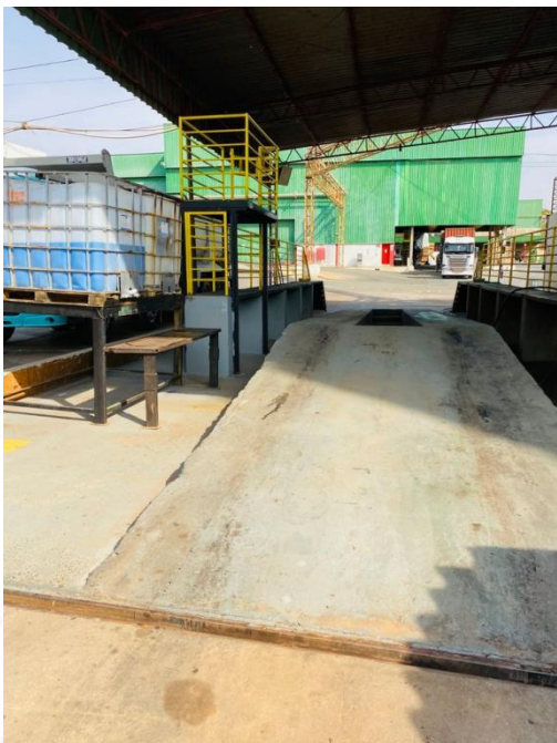
Foto 01. Lavador de veículos
