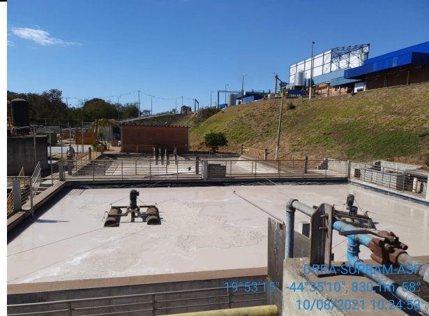
Foto 4 - Estação de tratamento de efluentes industriais
