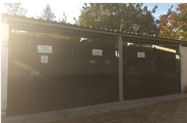
Foto 5: Baia de resíduos contaminados
