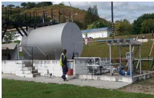
Foto 1: Área de tancagem
