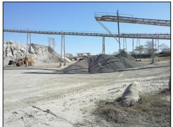
Foto 16: Área de britagem
