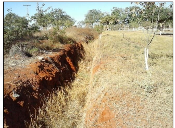
Foto 10: Drenagem de água Pluvial
