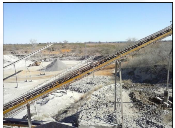
Foto 18: Área de britagem
