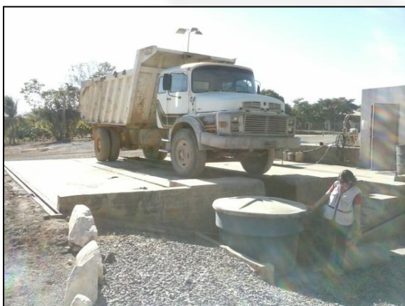
Foto 05: Área de lavagem e troca de óleo
