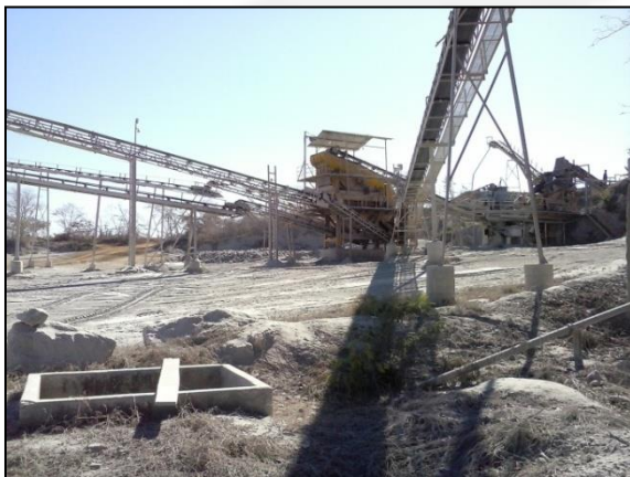
Foto 15: Área de britagem
