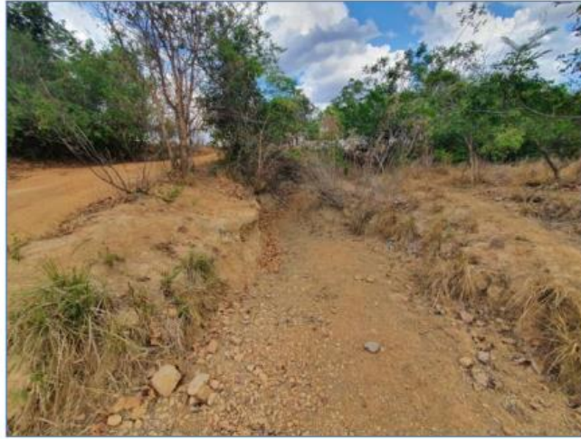
Figura 3-5 Solo erodido próximo ao Córrego Buriti
