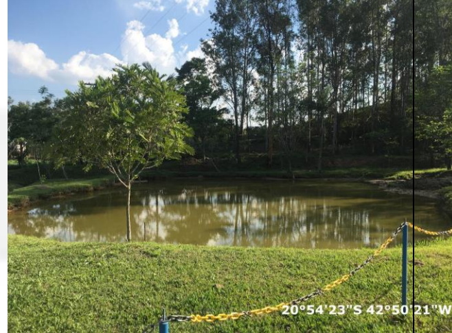
Foto 06: Lagoa de Decantação de Sólidos da Pedreira
