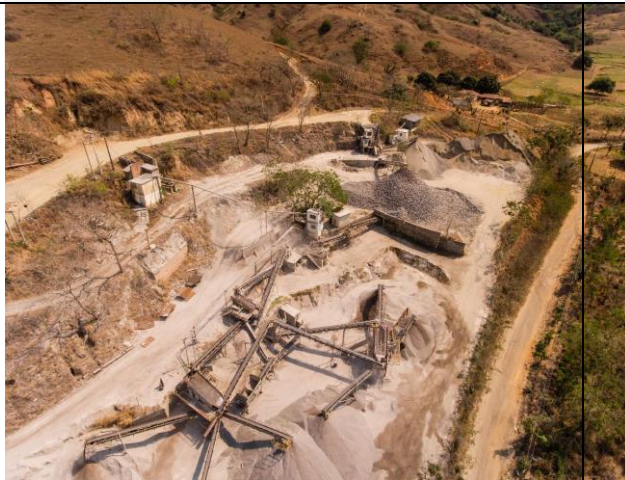
Foto 03: Vista aérea do pátio de britagem da Pedreira da MBC
