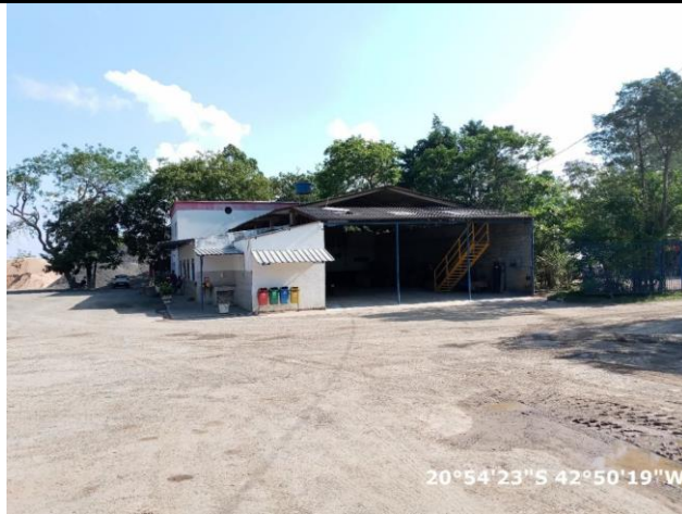
Foto 11: Vista da estrutura com o refeitório, almoxarifado, escritório e oficina da Pedreira MBC.
