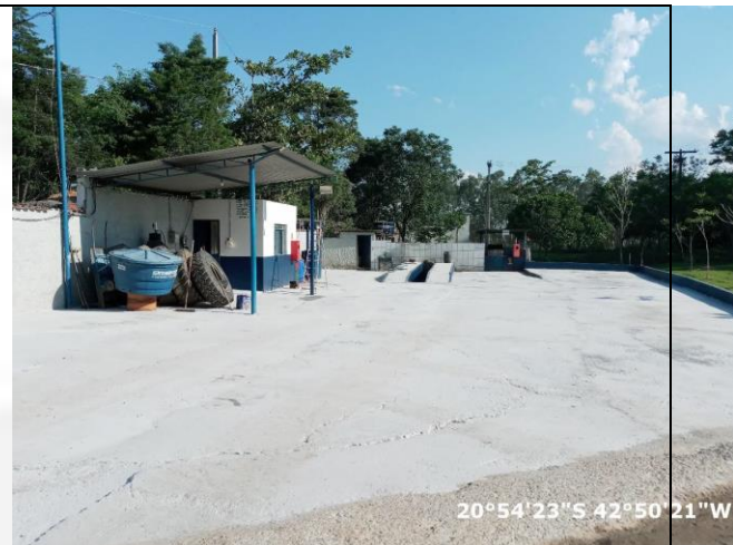
Foto 08: Vista do Lavador de veículos
