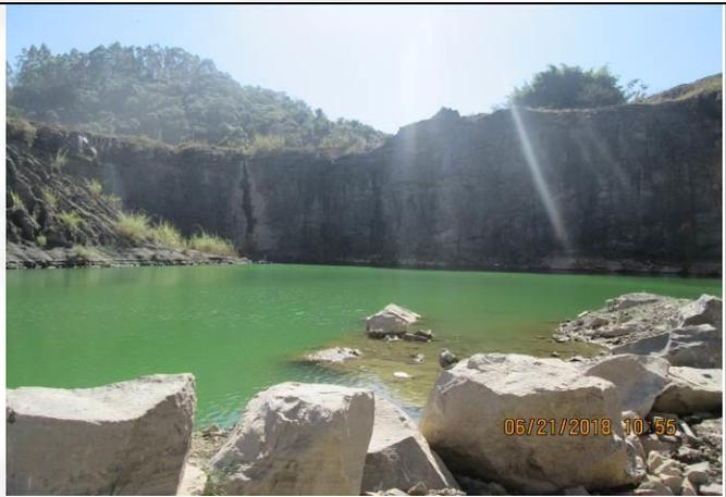
**Foto 6:** Vista do pit da cava paralisado coberto com água pluvial e subterrânea acumulada
