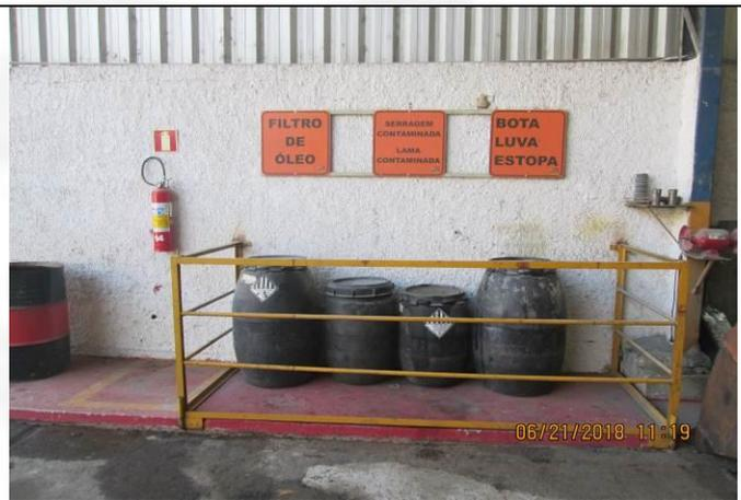
Foto 10: Local coberto e com piso impermeabilizado de coleta de resíduos sólidos
