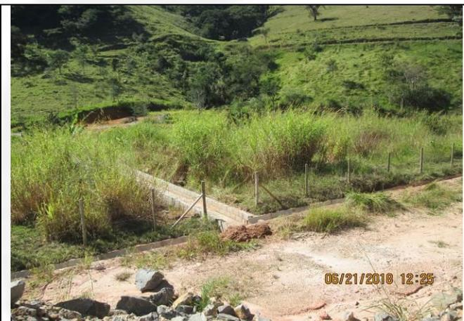
**Foto 19:** Drenagem pluvial da pilha de estéril Caeté
