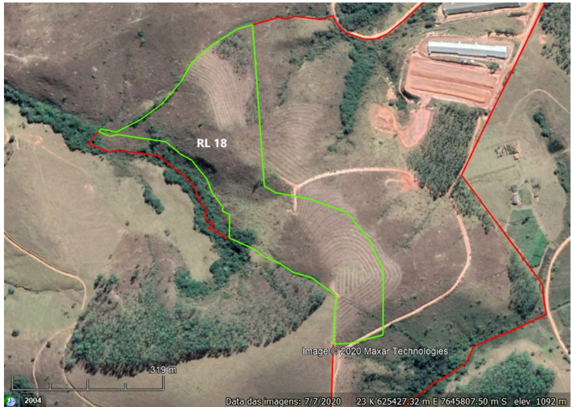
Imagem 5: Reserva Legal 18. Observa-se a área após o corte do plantio de eucalipto dentro da Reserva Legal. Imagem de 07/07/2020
