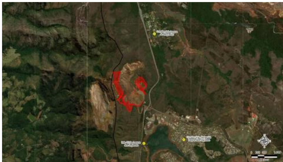
Figura 15. Localização do empreendimento e condomínios do entorno. Fonte: autos do PA nº 00012/1988/032/2017.
