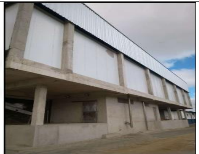
Foto 04. Sala de desossa
