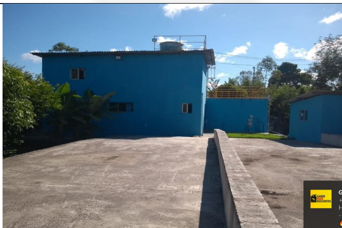
Foto 05. Estação de Tratamento de Água (ETA)
