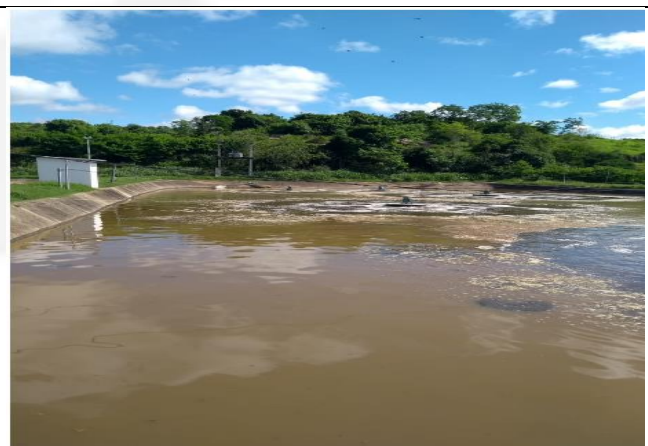
Foto 06. Lagoa da Estação de Tratamento de Efluentes (ETE)
