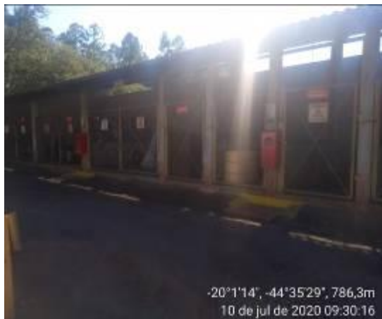
Foto 07. Área separação e armazenamento RS
