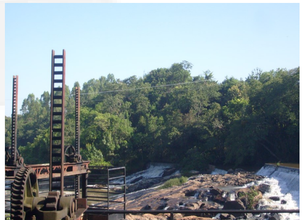
Foto 04. Trecho de vazão reduzida
