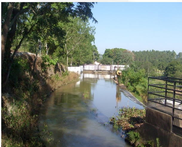
Foto 03. Canal de adução.
