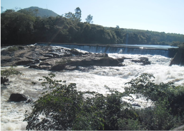
Foto 05. Trecho de vazão reduzida, barramento e reservatório
