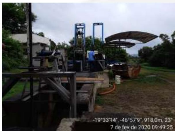
**Foto 01.** Tratamento preliminar - gradeamento e peneiramento
