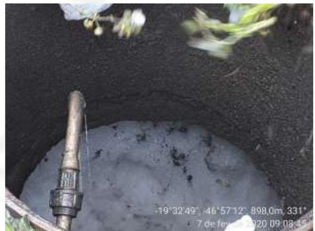
**Foto 08.** Inserção do produto para redução de espuma antes do lançamento
