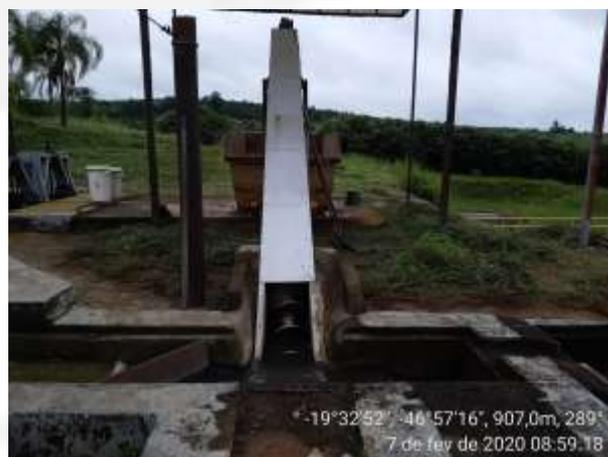
**Foto 02.** Recolhimento dos sólidos retirados do desarenador aerado
