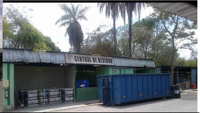
Foto 08: Central de resíduos
