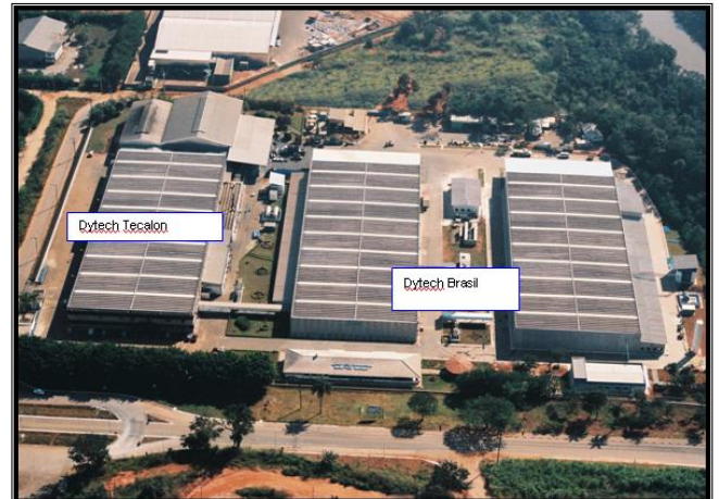
Figura 03: Estação de Tratamento dos Efluentes Sanitários da Dytech Tecalon Indústria e Comércio de Autopeças Ltda., em conjunto com a empresa Dytech do Brasil Indústria e Comércio Ltda.
