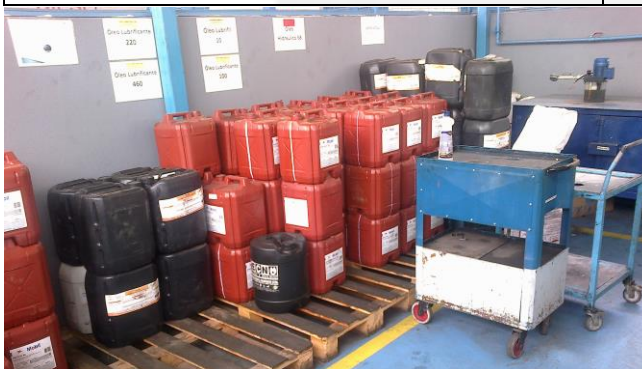
Foto 5: Local de armazenamento de óleos
