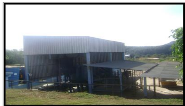
ESTAÇÃO DE TRATAMENTO DE EFUENTES INDUSTRIAIS – FÍSICO QUÍMICO
