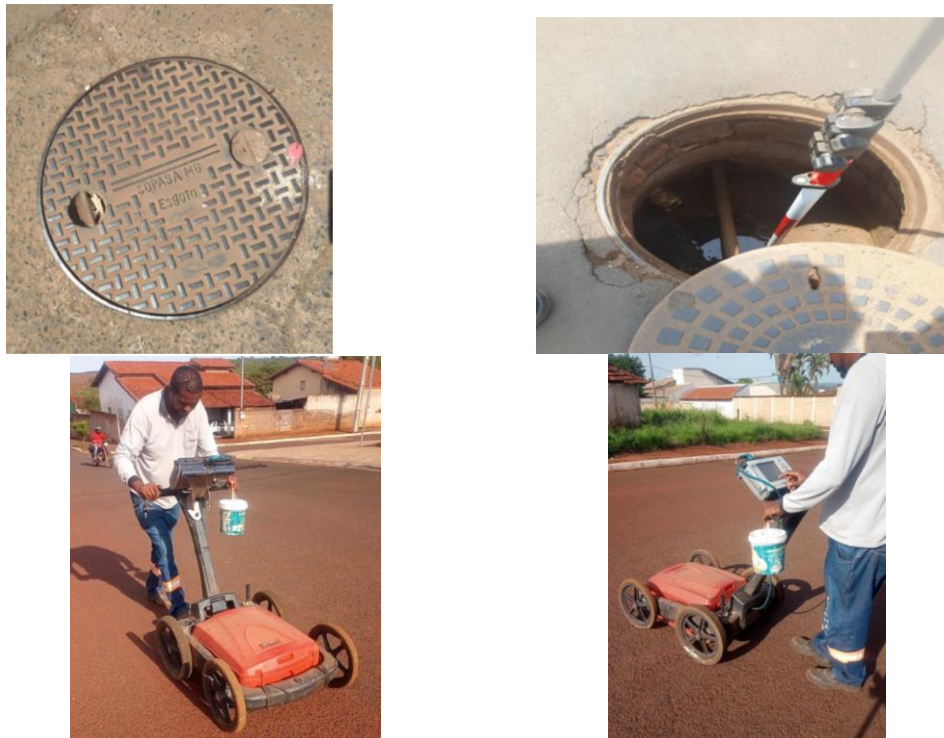
Registro dos serviços realizados com o GRP (GeoRadar) no município de Perdizes – MG.
