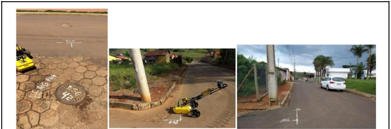
Registro da localização de rede e PV, marcação em piso, GRP (GeoRadar) e marcação no piso e na via no município de Indianópolis.
