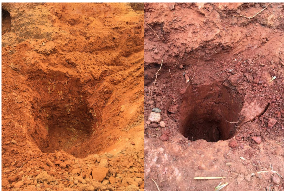
Figura11: Condições aparentes de coloração e compactação do solo. Alaranjada (Ponto 01) e Amarronzada (Ponto 02).
