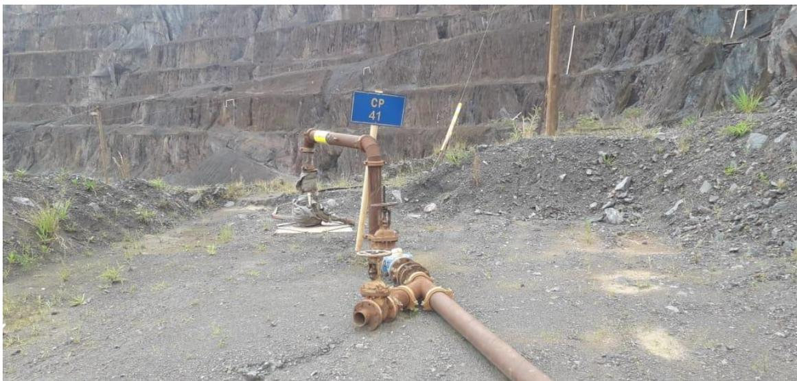
*Figura 9: Evidências das instalações dos medidores de vazão, de nível e do registro para coleta de água do CP 41.*
